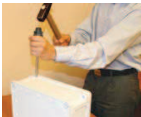
1. Удалите соединительные отверстия
