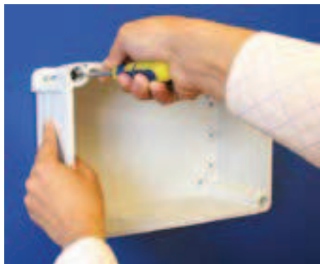
1. Прикрутите корпус к стене
